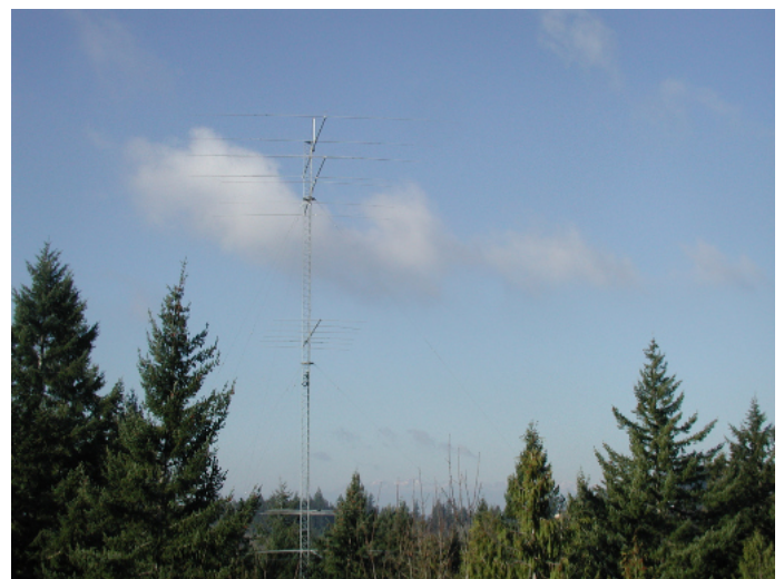
Die Antennen von W7VJ.
